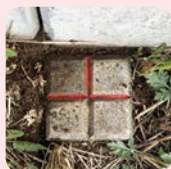
コンクリート杭
