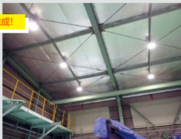
屋内用遮熱シート設置工事の様子
