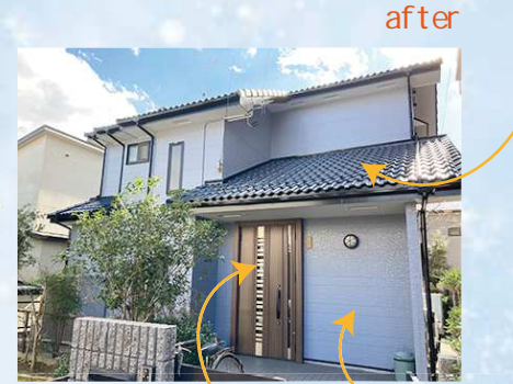
玄関ドア取替 外壁塗装
